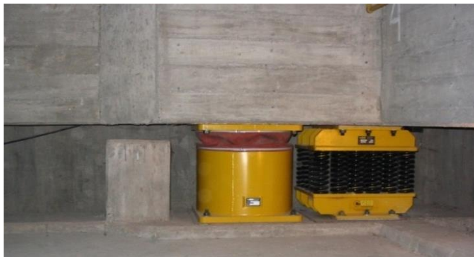
Рисунок А.12 – Установка ТПДС при параллельном размещении блока витых пружин и вязкоупругого демпфера
